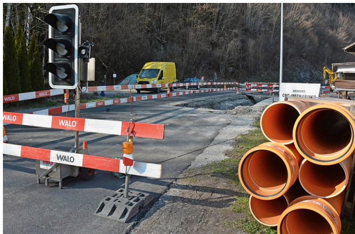
Die Kantonsstrasse Wimmis–Reutigen: Ende Juni soll der Verkehr beim Brodhüsi wieder ungehindert rollen. Foto: Guido Lauper
